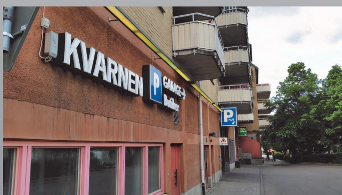
Nedfart till Kvarnengaraget, som ligger i direkt anslutning till Kvarnengallerian med affärer, systembolag, apotek samt restauranger.
