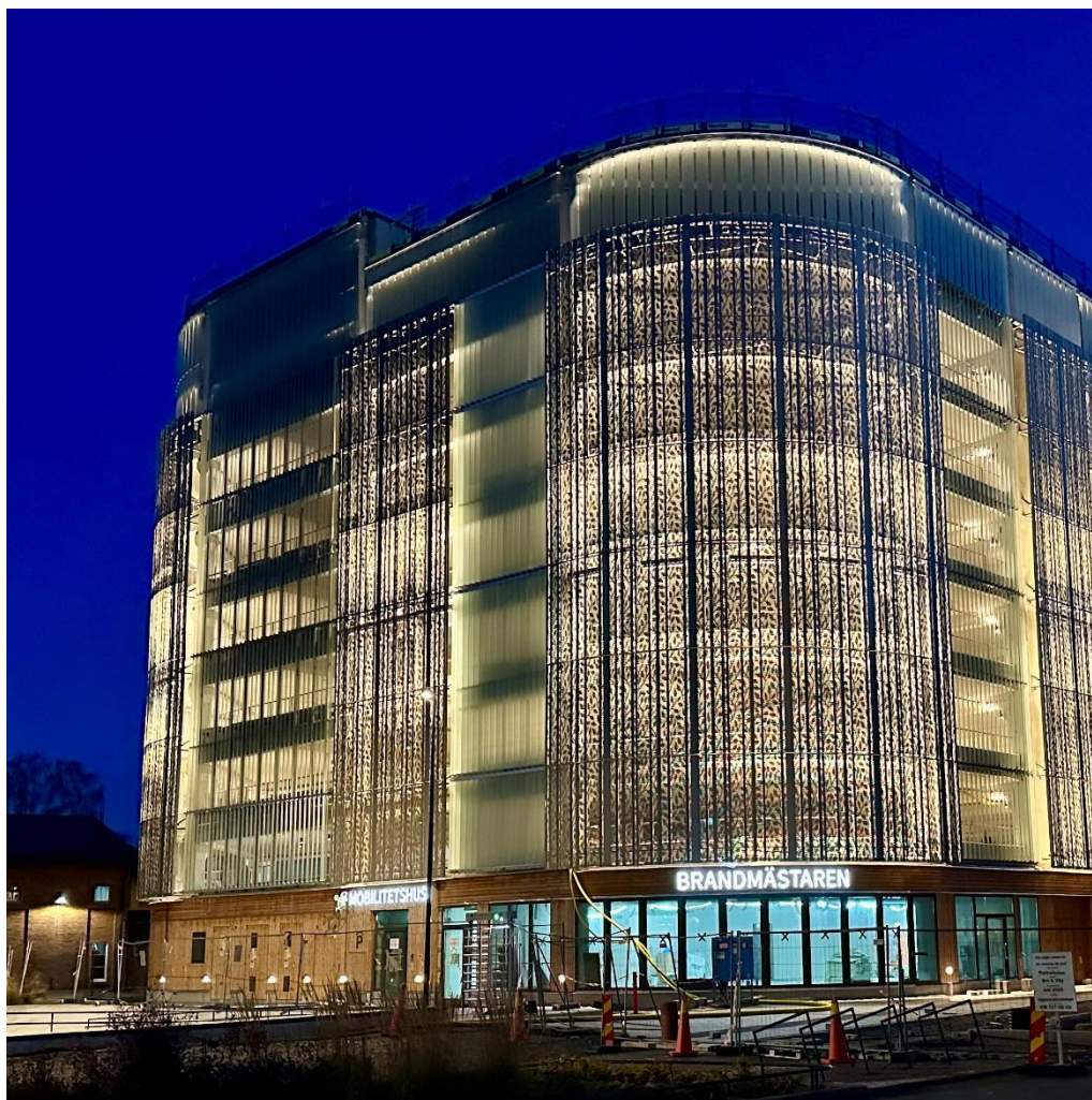
Mobilitetshuset Brandmästaren under uppbyggnad. Med trygghetsskapande belysningsdesign och klimatmedvetna materialval.
