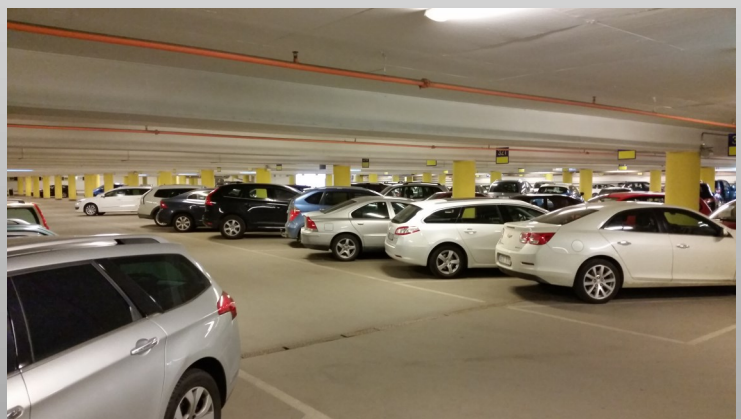
Under hösten 2015 byttes den gamla belysningen på övre planet i Centralgaraget ut till modern och energibesparande LED-belysning, som ett led i bolagets strategi med ljusa, trygga och energisnåla parkeringsanläggningar.
